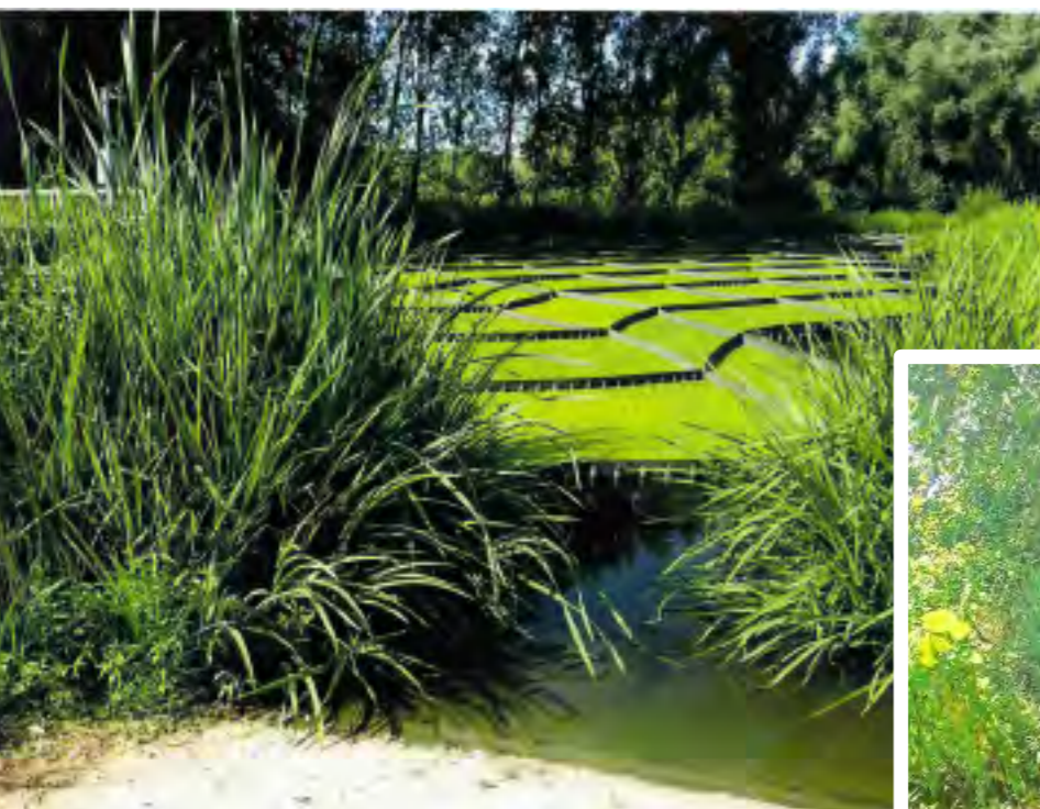
Het waterzuiveringsstation uit 1993 nabij pachthof Bilande, beheerd door de Waalse intercommunale INBW. Eendenkroos, Lemna (de groene 'vlakken' op het water), helpt bij de waterzuivering, wordt ten gepaste tijde geoogst, gedroogd en kan nadien als veevoeder gebruikt worden.
